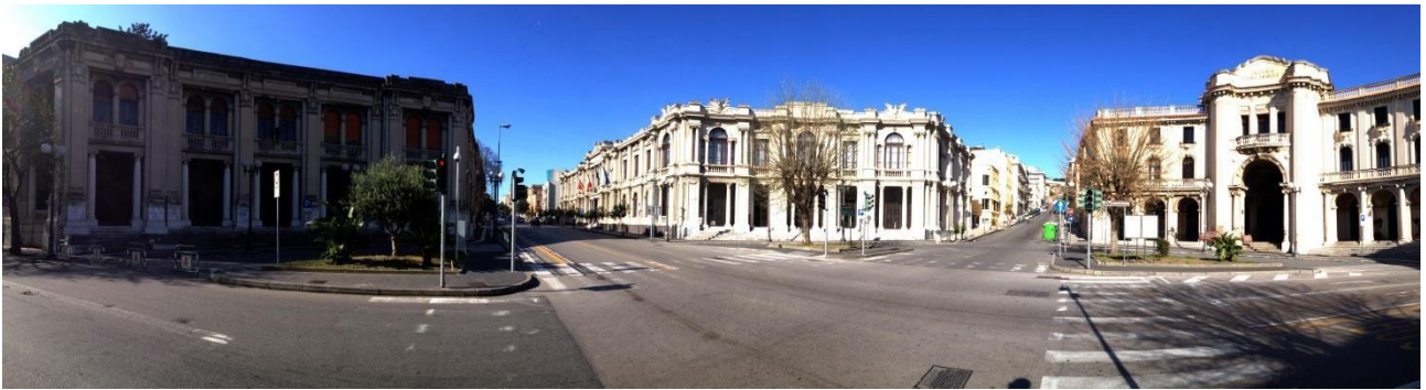
Il Palazzo delle Poste
