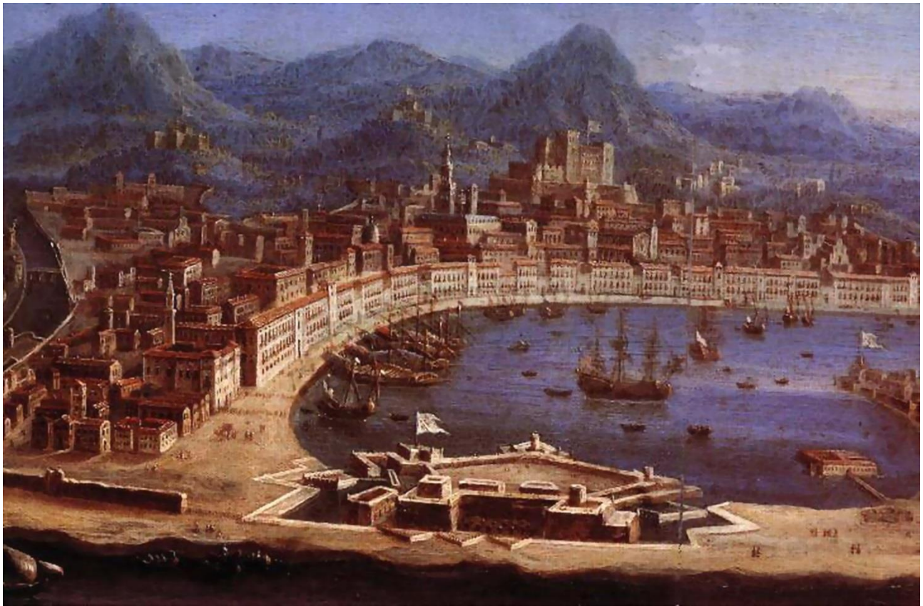
Messina – La Palazzata di Simone Gulli
